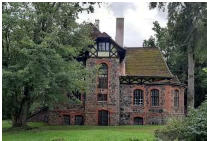
Foto 3 – Vaade peahoone loodefassaadile (05.09.2020) autor Olav Remmelkoor, vaatesuund vt joonisel 2
